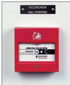
Déclencheur à membrane
