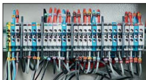
Bornier intégré dans l'armoire
