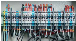
Bornier intégré dans l'armoire
