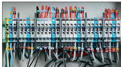
Bornier intégré dans l'armoire
