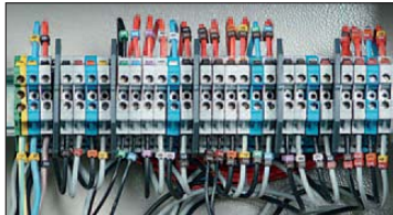
Bornier intégré dans l'armoire
